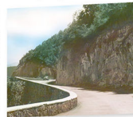
Figura 4.25 Los rezagos de México con respecto a nuestro vecino del norte o a países europeos y asiáticos, no se podía (ni se puede) eliminar de la noche a la mañana. Los caminos, por ejemplo, se tenían que transformar en carreteras e incluso en autopistas. Aquí ves una tarjeta postal de la carretera de México a Cuernavaca. Pregunta a personas de edad qué eran las postales y en grupo comenten su vigencia hoy en día y si tienen un equivalente digital.
