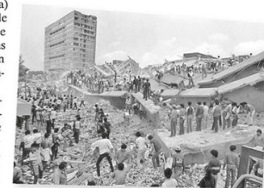
Figura 5.16 La Ciudad de México, tras el sismo de 1985, se quedó sin agua, sin teléfono, sin luz; varias estaciones del Metro dejaron de funcionar; los servicios de salud no fueron suficientes, pues los hospitales más grandes habían quedado en ruinas. Cuando llegó la noche cientos de personas no tenían casa donde dormir, lo habían perdido todo. Sin embargo, los ciudadanos se organizaron para, de mil maneras, ayudar a los damnificados.
